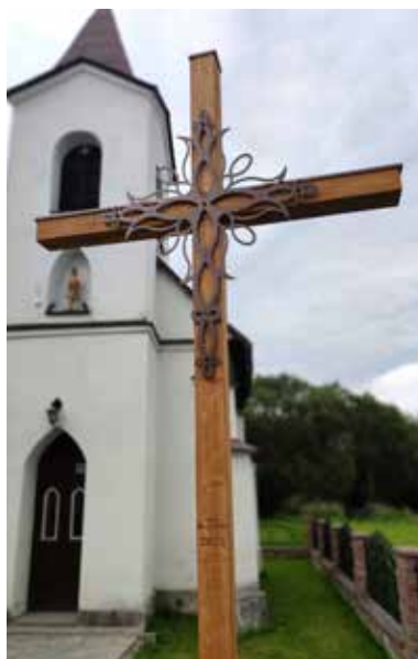
Kaplica wybudowana w 1900 roku
